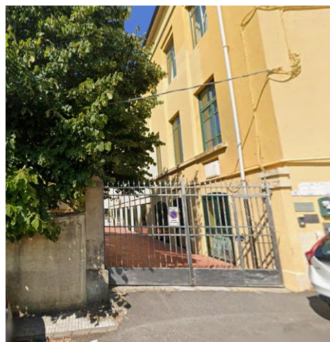
Figure 8 Cannello ingresso da via Cammeo
